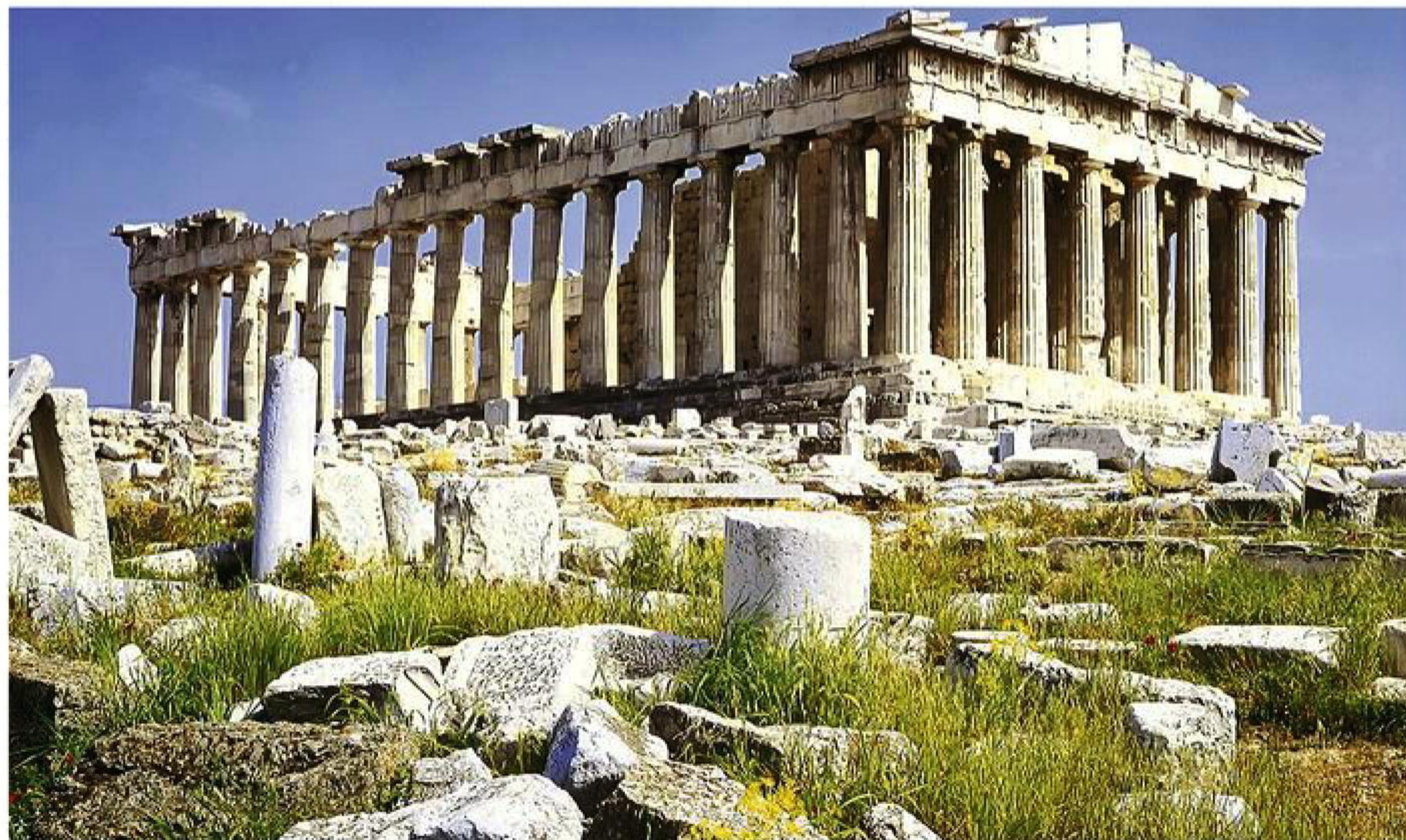
Стойчно-балочная система перекрытий Афинского акрополя: стойки – колонны, балки – архитравы
