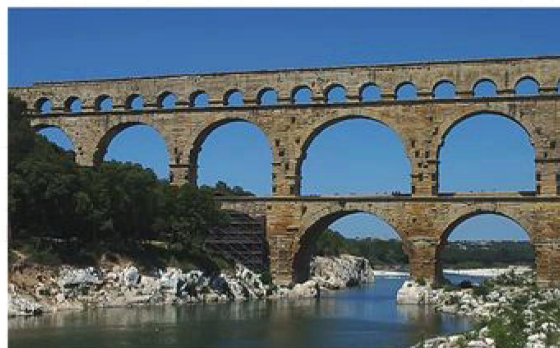
Арочно-купольная система перекрытий: нагрузка распределяется скругленными арками
